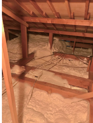
施工後 天井裏写真
